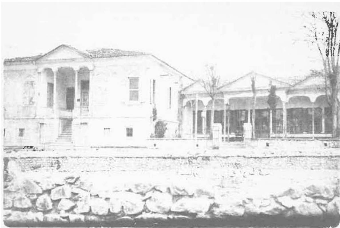
9. Όχθες του Τσάι στη Σπάρτη. Κατοικία κι εργοστάσιο χαλιών Δουρμπέο- γλου.
