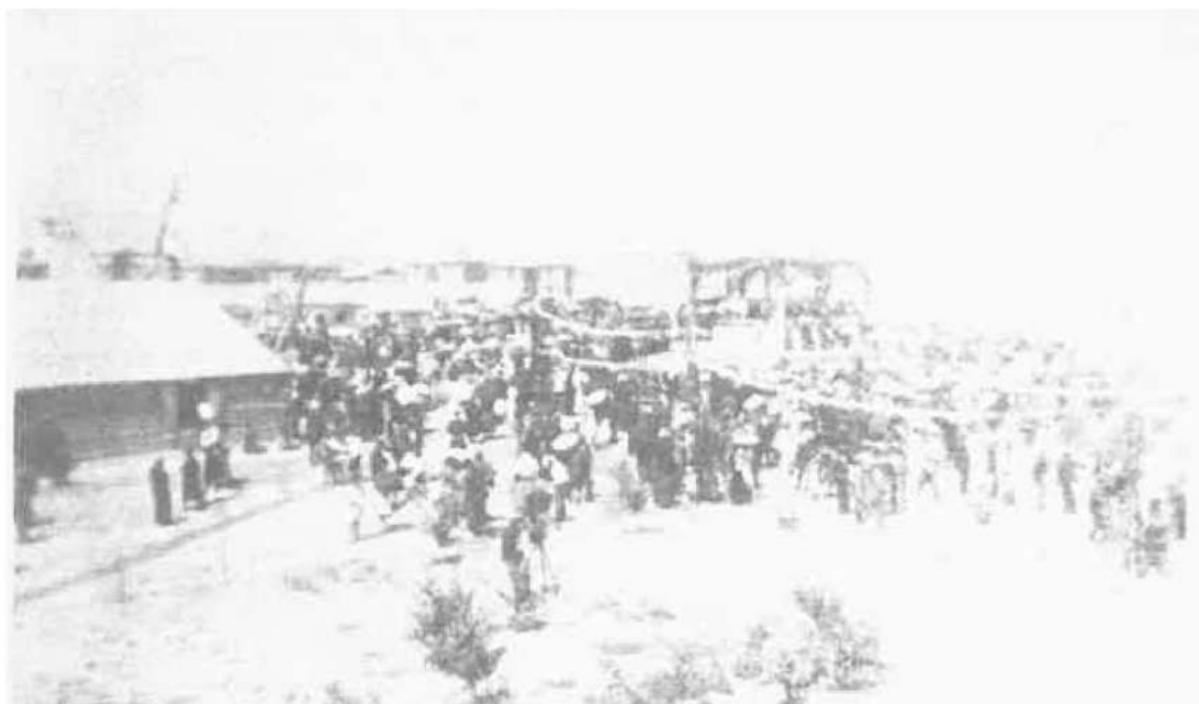
19. Από τη θεμελίωση του Ιερού Ναού των Αγ. Αναργύρων (1928). (Ανέκδοτη φωτογραφία, προσφορά Πνευμ. Κέντρου Δήμου Ν. Ιωνίας).
