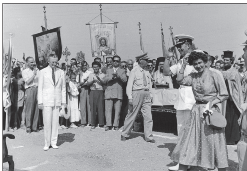
Θεμελίωση Δημ. Σχολείου Καλογρέζας.
