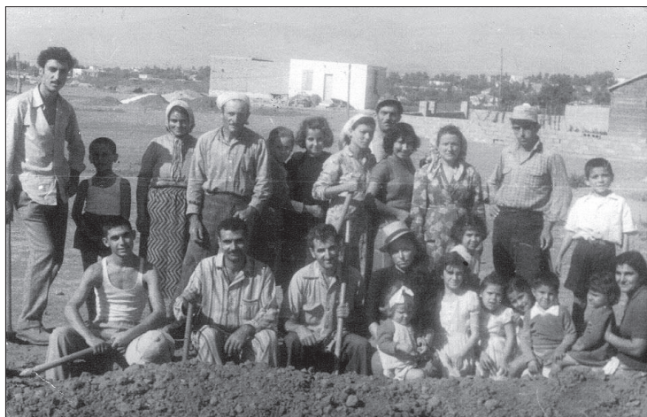
1956. Κάτοικοι της οδού Μεσσηνίας, τοποθετούν σωλήνες ύδρευσης.
