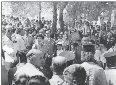
Θεμελίωση Δημ. Σχολείου Σαφραμπόλεως.
