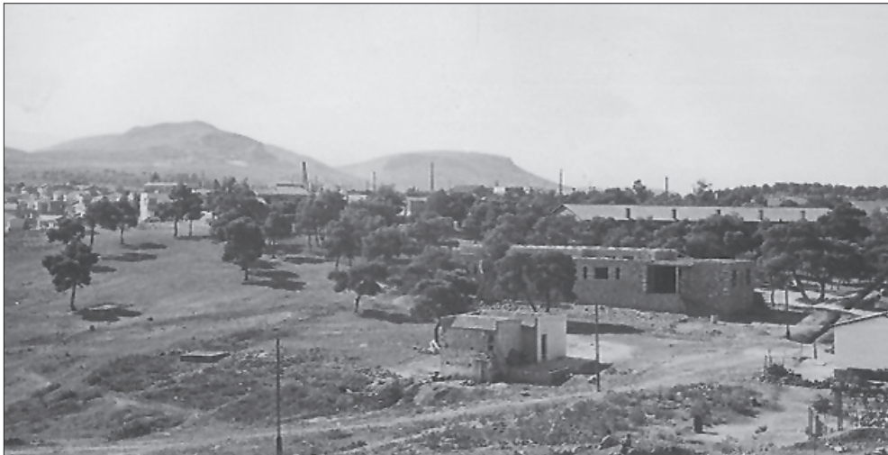
1951. Κατασκευή σχολείου Σαφραμπόλεως.
