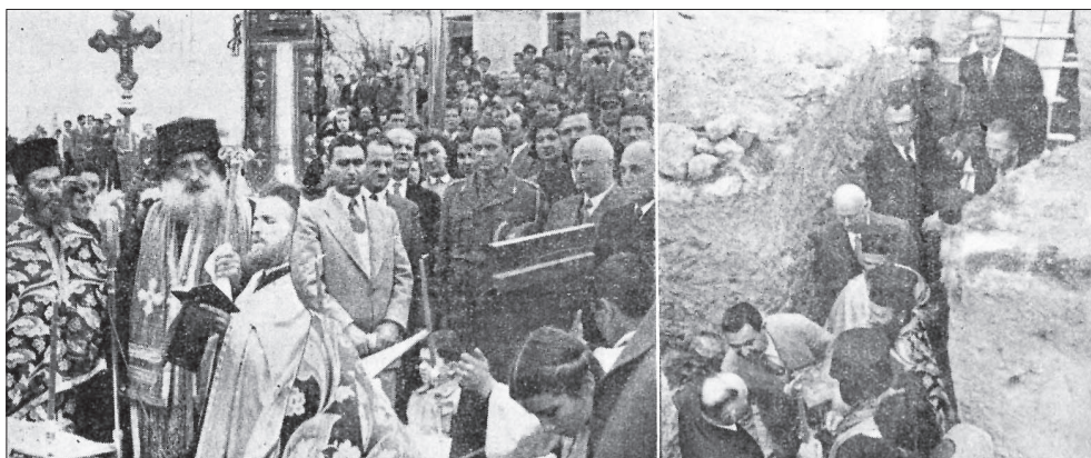
4 Απριλίου 1954. Από τη θεμελίωση του Ιερού Ναού της Αγ. Αναστασίας.
