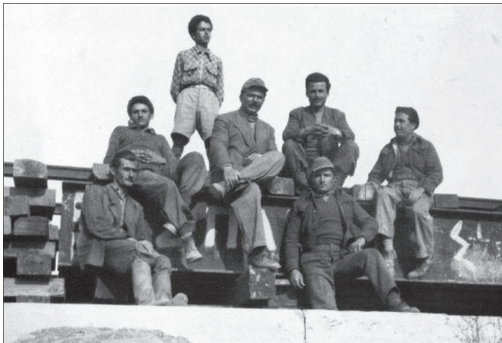
Εργάτες του λιγνιτωρυχείου πάνω στην σιδηροδρομική γέφυρα Ηρακλείου-Λαυρίου.
