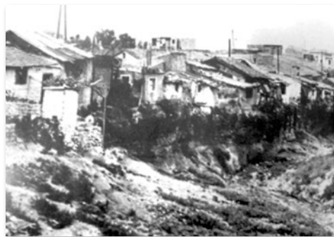
Οι κατοικίες δίπλα στο ρέμα (Ντερές)
