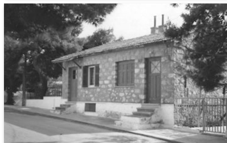
Νεόκτιστα Ν. Ερυθραίας (1995). Κρατικές διπλοκατοικίες του 1928 (πάνω, στην οδό Γραβιάς 18-16) και του 1938 (κάτω, στην οδό Αλατσάτων 11-13, φωτ. αρχείο Θ. Κοντάρα).
